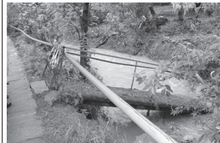
Zerwany mostek w Jasionce.
