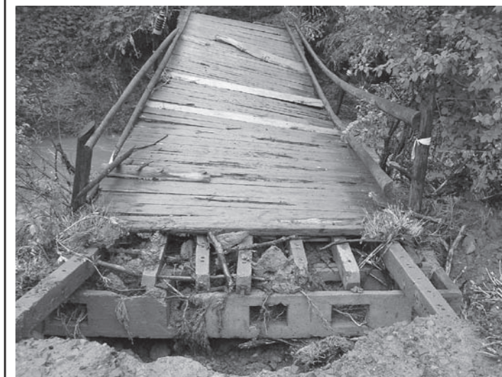
Zniszczony mostek w Zawadce Rymanowskiej.
