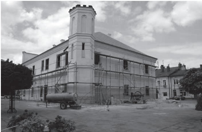
Remont elewacji dukielskiego ratusza
