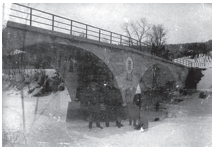
Żelbetonowy most na Jasiołce w Zboiskach-Popardach z lat 1925/1926
