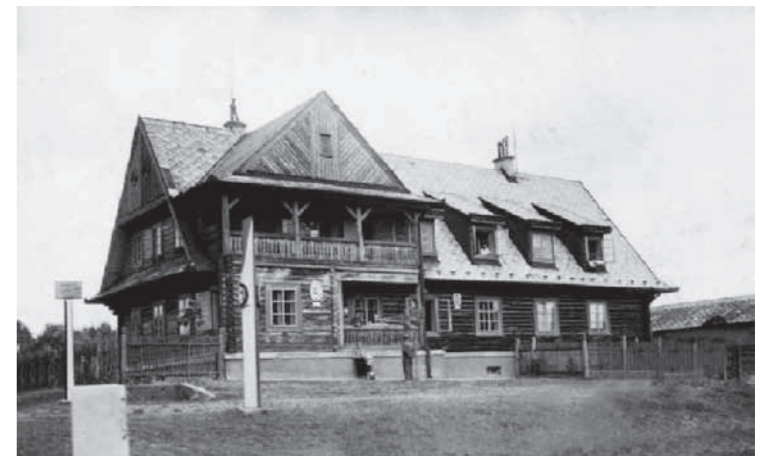
Vyšný Komárnik – budynek słowackiego urzędu celnego i oddziału straży finansowej pamiętający czasy monarchii habsburskiej, z lewej strony zdjęcia widoczny graniczny słup główny XV/1 (zbiory autora)
