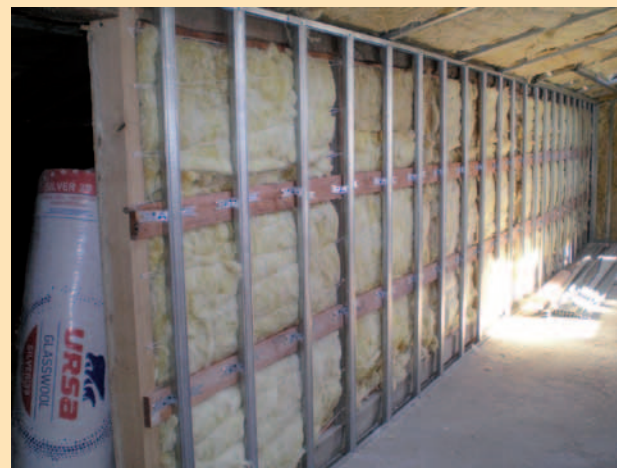
Prace remontowe w pomieszczeniach Regionalnego Centrum Kultury
