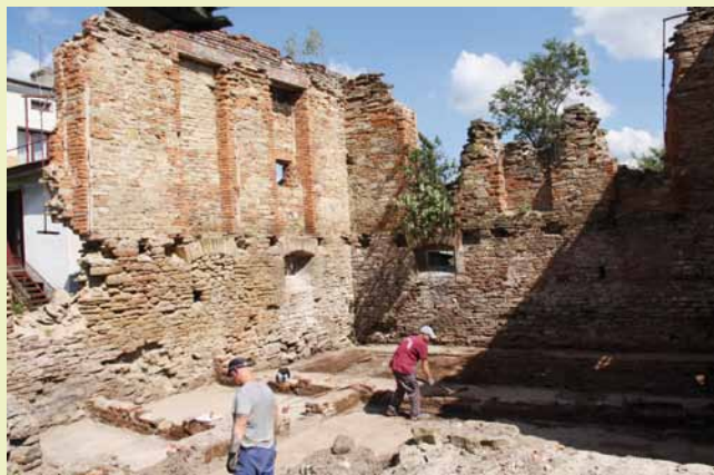
Prace porządkowe w Komorze Celnej
