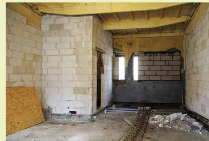
Prace wykończeniowe w toku
