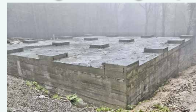
Fundament i płyta pod wieżę na G. Cergowej. Fot. Agnieszka Matusik
