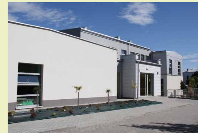
Budynek przedszkola po zakończeniu prac
