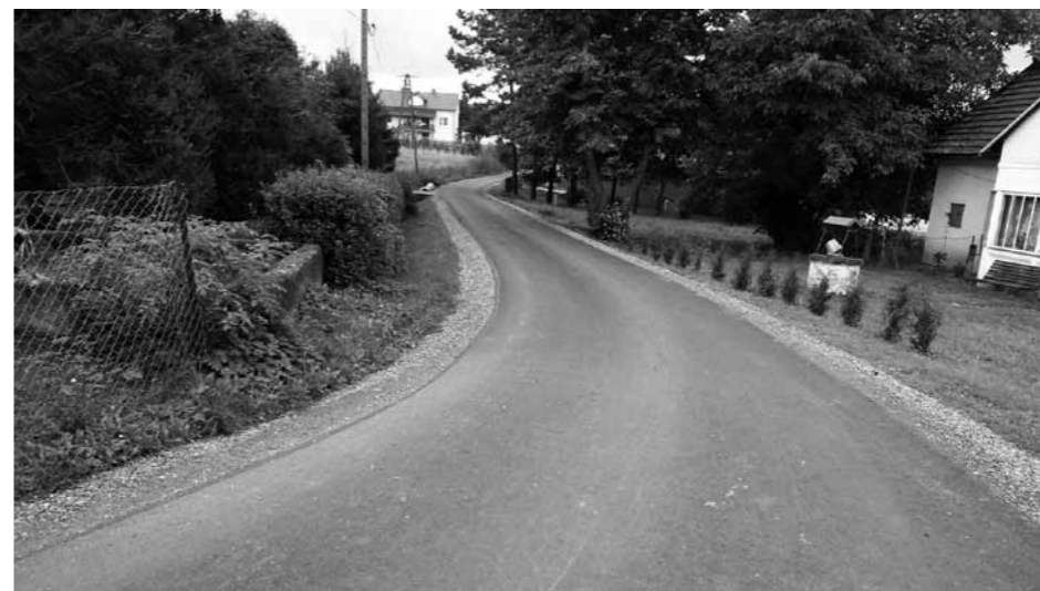
Wykonanie nakładki asfaltowej na drodze gminnej nr ewid. 2125 w Łękach Dukielskich
