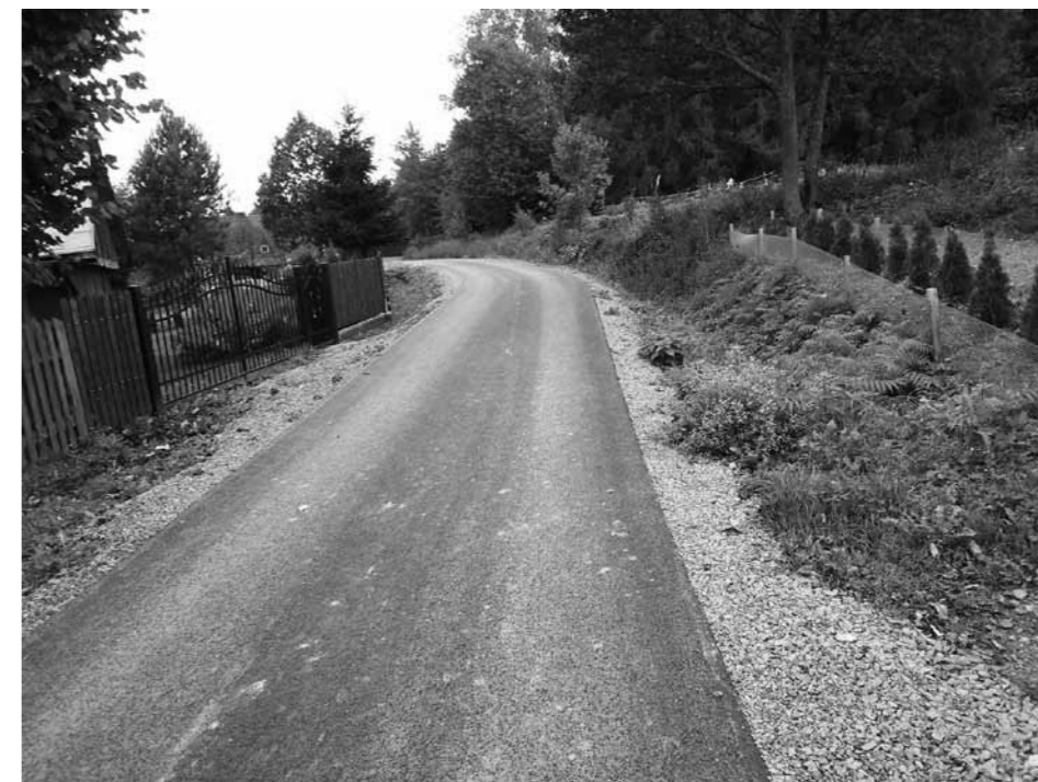
Wykonanie nakładki asfaltowej na drodze wewnętrznej nr ewid. 396 w Myszkowskim
