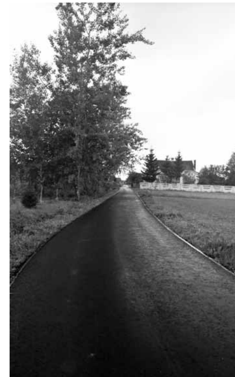
Wykonanie nakładki asfaltowej na drodze wewnętrznej nr ewid. 1326 w Teodorówce
