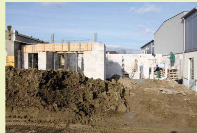
W trakcie budowy
