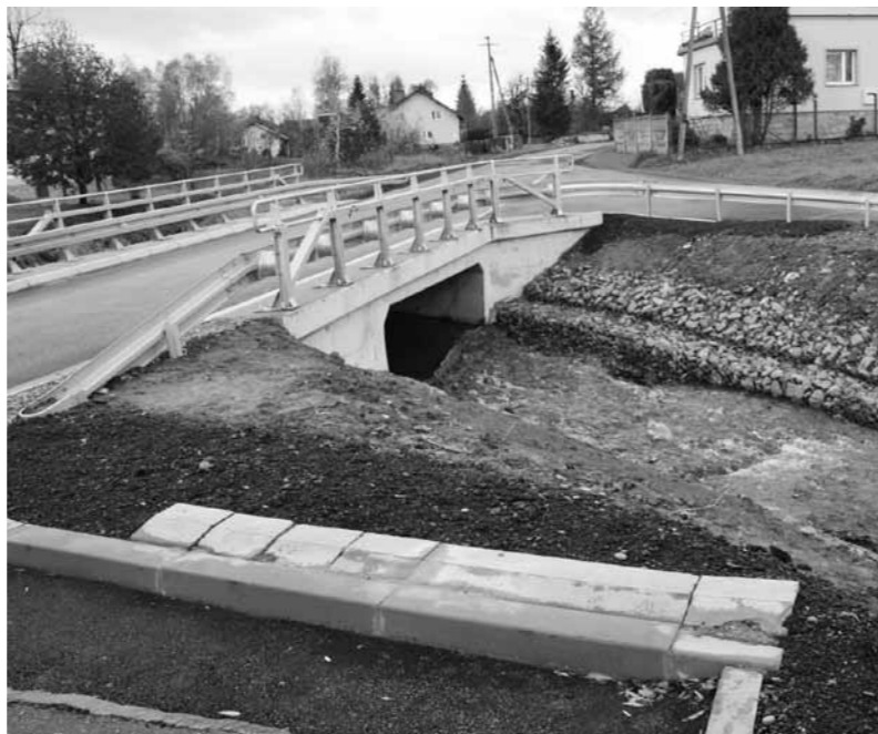
Przepust w Teodorówce po remoncie
