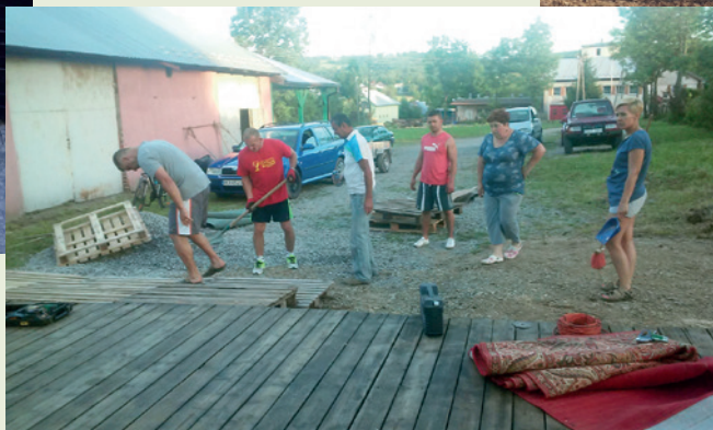
Prace porządkowe - otoczenie Domu Kultury
