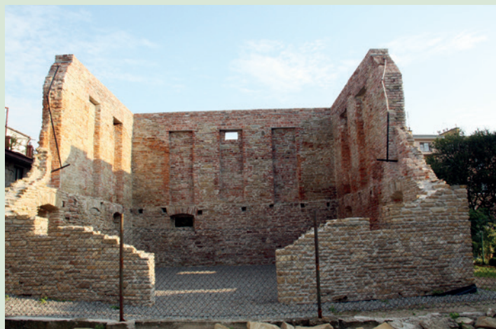
Ruiny komory celnej w Dukli po pracach konserwatorsko-zabezpieczających
