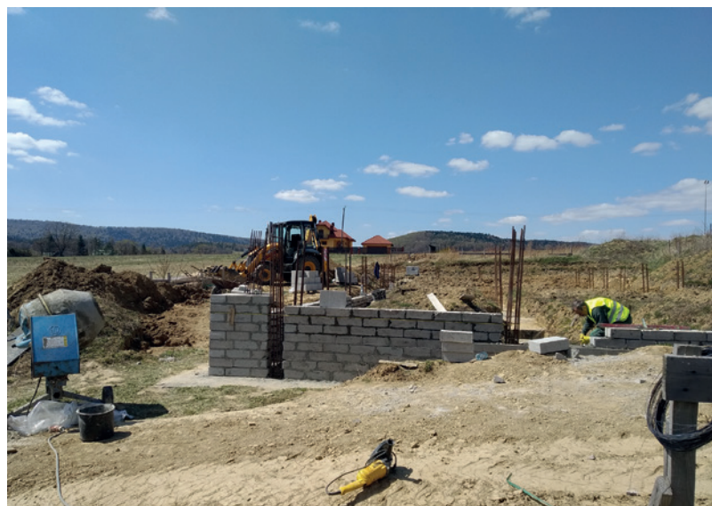
Na placu budowy. Fot. Piotr Świder
