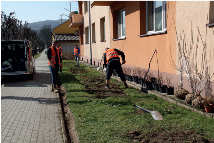
Prace przy rabatach na ul. Kościuszki
