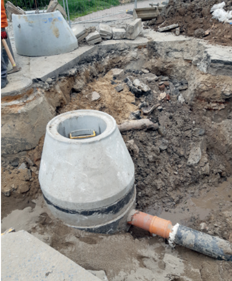
Nowa studnia kanalizacyjna
