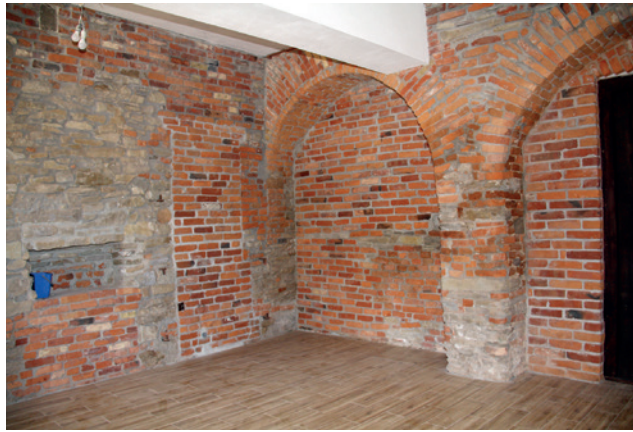
Pomieszczenie na przyszłą restaurację i kawiarnię
