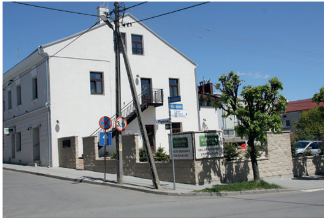
Remont kamienicy przy ul. Rynek 16 zakończony
