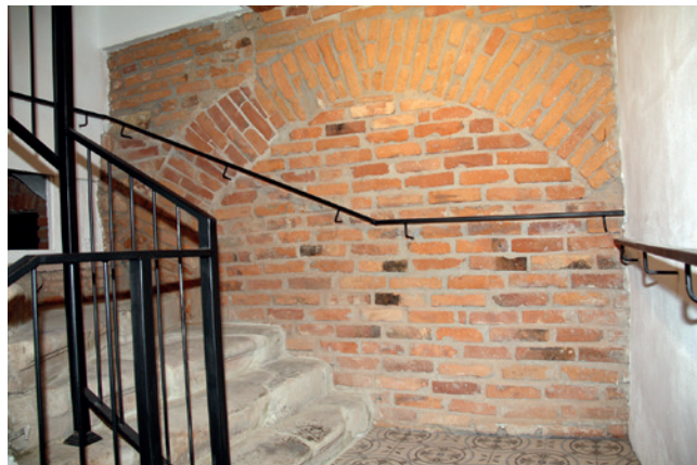
Klatka schodowa ze starymi schodami z piaskowca prowadząca do apartamentu na 1. piętrze
