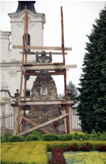
Figura z rusztowaniem w czasie prac konserwatorskich
