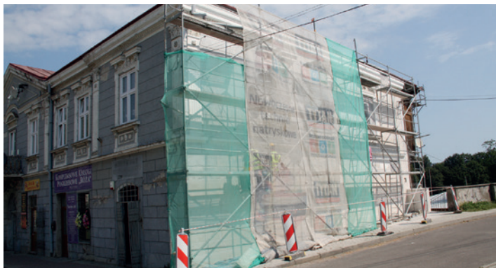
Elewacja południowa i część fasady kamienicy Springera
