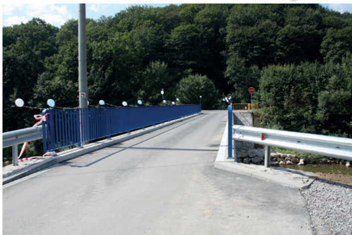
Wyremontowany most na rzece Jasiołce w Nowej Wsi
