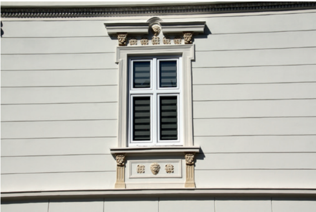
Odrestaurowane okno elewacji południowej w profilowanej opasce z fryzem dekorowanym rozetami
