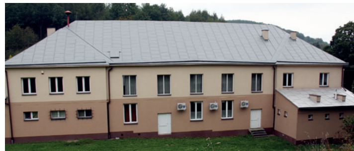
Dach Domu Ludowego w Wietrznie po konserwacji
