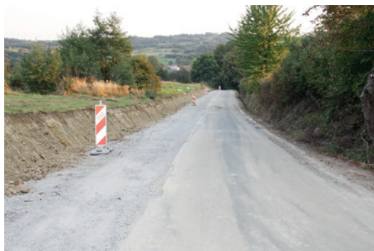
Droga na Myszkowskim przygotowana do położenia nawierzchni asfaltowej
