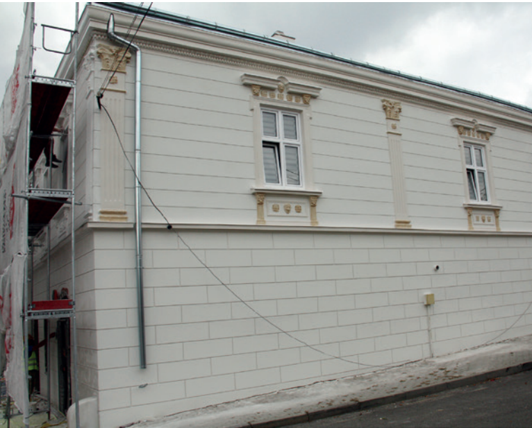
Odrestaurowana elewacja południowa
