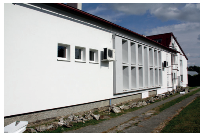
Elewacja południowa w trakcie prac
