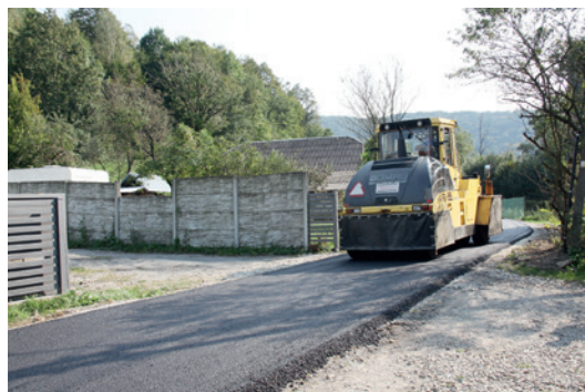
Kładzenie nawierzchni asfaltowej na drodze w Cergowej (Zakluczyna)
