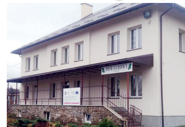
Odnówione elewacje Domu Ludowego w Cergowej
