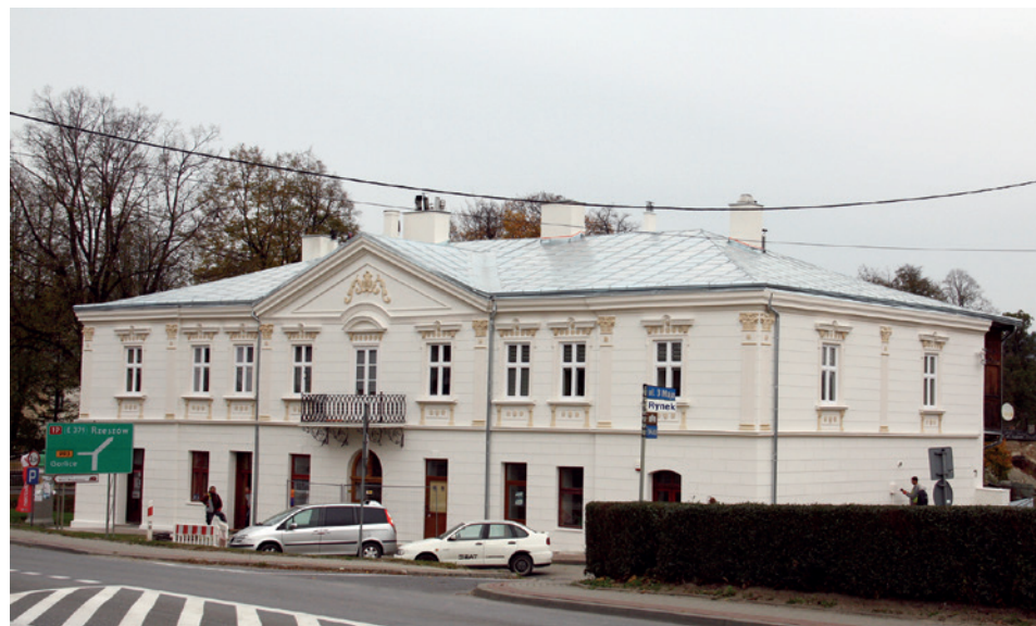
Kamienica przy ul. 3 Maja 1 po renowacji trzech elewacji, dachu i drzwi wejściowych
