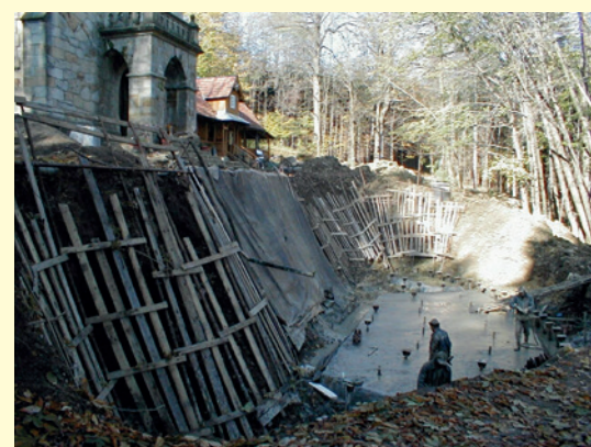
Prace zabezpieczające kociołek przed osuwiskiem ziemnym na Pustelni św. Jana z Dukli w Trzcianie 2001 rok
