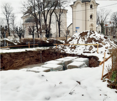
Przygotowanie placu budowy i rozpoczęcie prac
