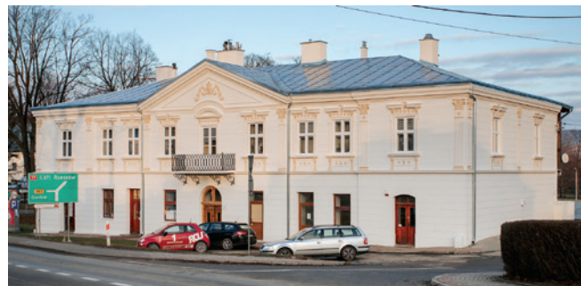
Odnowione elewacje: frontowa i południowa kamienicy
