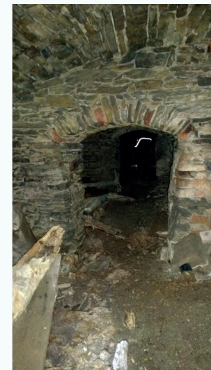
Piwnica pod budynkami pierzei zachodniej
