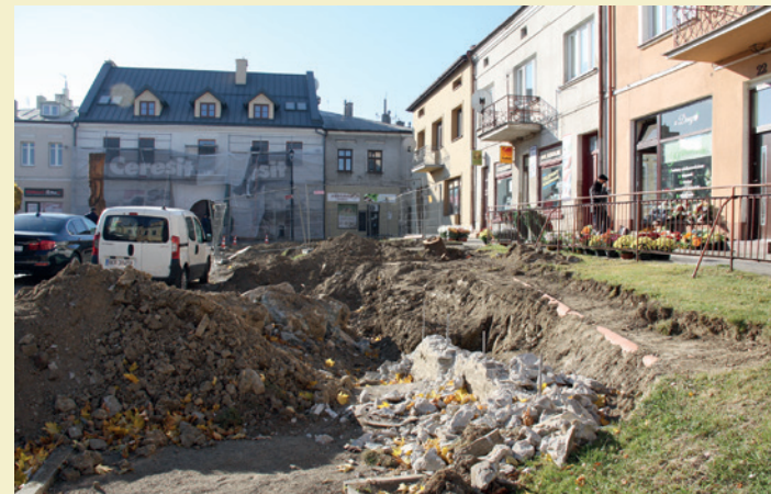
Rozkopane wejścia do piwnic - pierzeja zachodnia rynku
