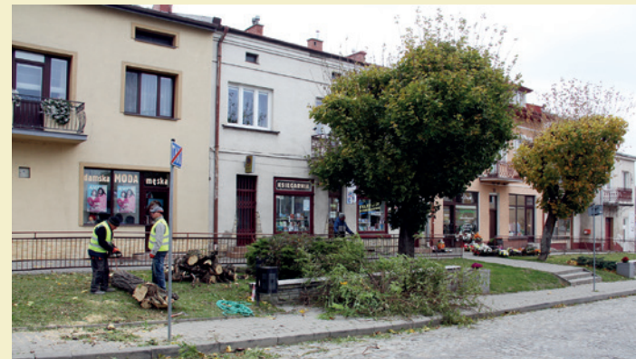
Rozpoczęcie prac zaczęło się wycinąk drzew
