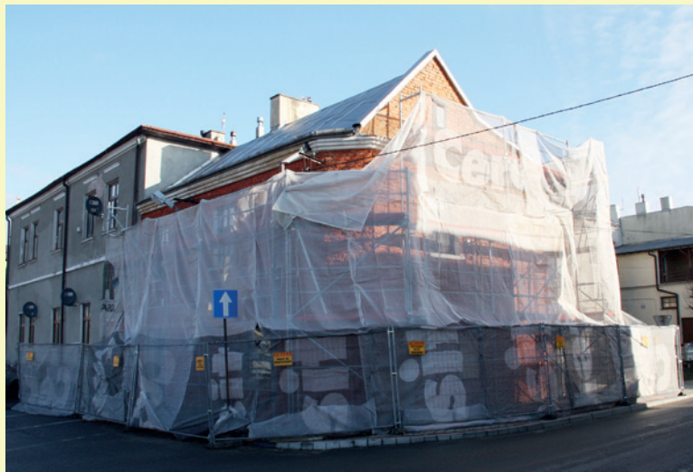
Zabezpieczona elewacja remontowanego budynku. Fot. kbr
