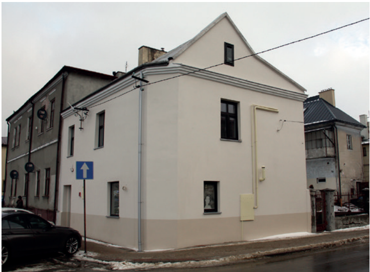
Odnowiona elewacja zachodnia i południowa
