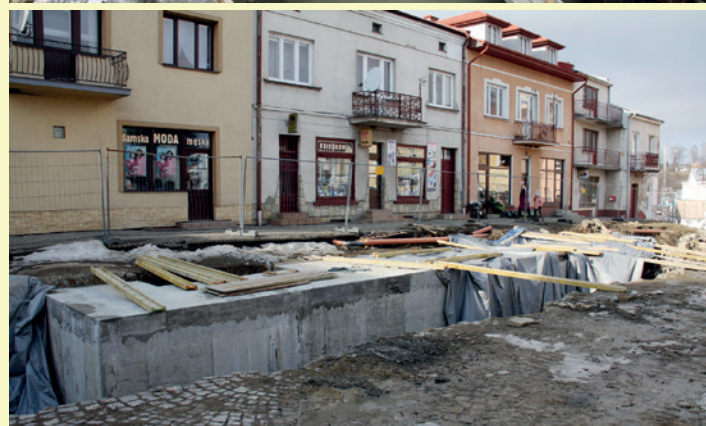
Przygotowywanie korytarzy podziemnych do wejścia, do piwnic pierzei zachodniej rynku
