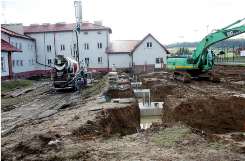
Budowa fundamentów hali
