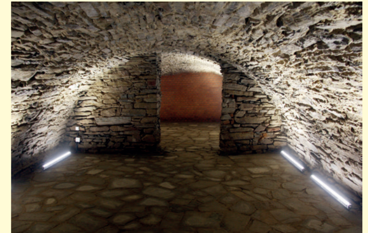
Piwnice - zakończenie prac wrzesień 2022
