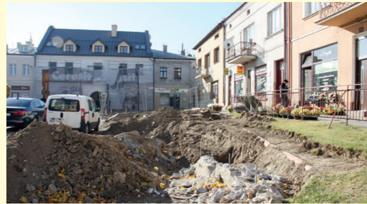
Piwnice - październik 2021 - rozpoczęcie prac
