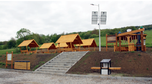
Widok ogólny obiektu
