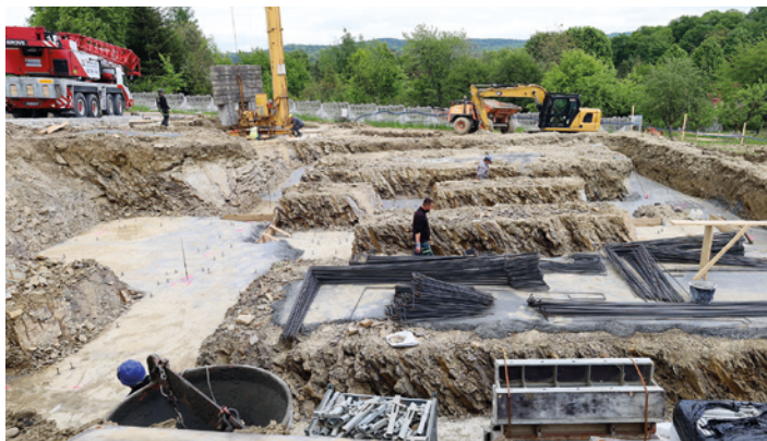
Wykop pod fundament
