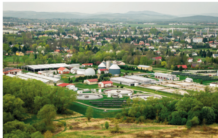
Oczyszczalnia ścieków w Krośnice
