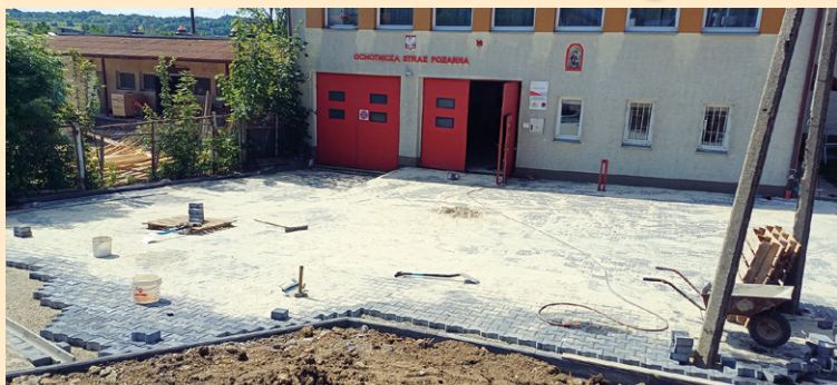
Prace na placu
