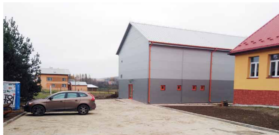
Widok ogólny na budynek hali sportowej w Jasionce z placem postojowym i chodnikami
