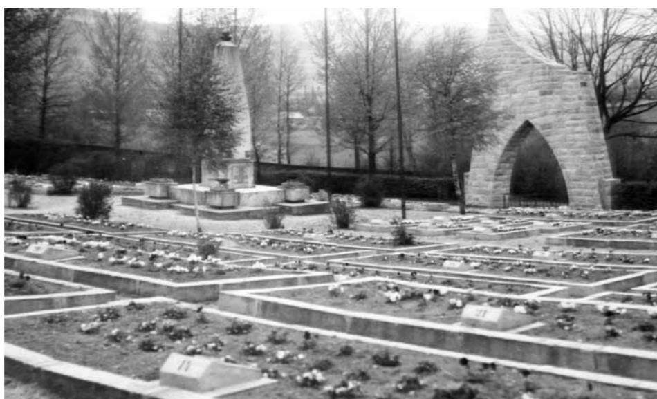
Brama cmentarza wojennego w Dukli po zakończeniu realizacji – widok z wnętrza cmentarza. Widoczny jeszcze stary pomnik. Według zdjęcia wykonanego przez Władysława Wilka (br. January OFM) wykorzystanego do wykonania widokówki przez Zakłady Wytwórcze Fotowidokówek w Jaśle PTTK
