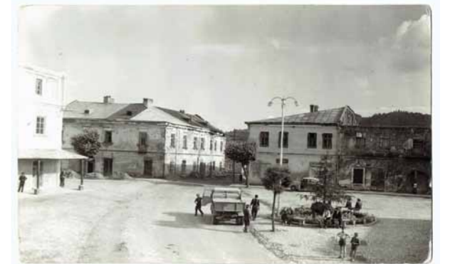
Budynek nr 25 na dukielskim Rynku na początku odbudowy końcem lat pięćdziesiątych
