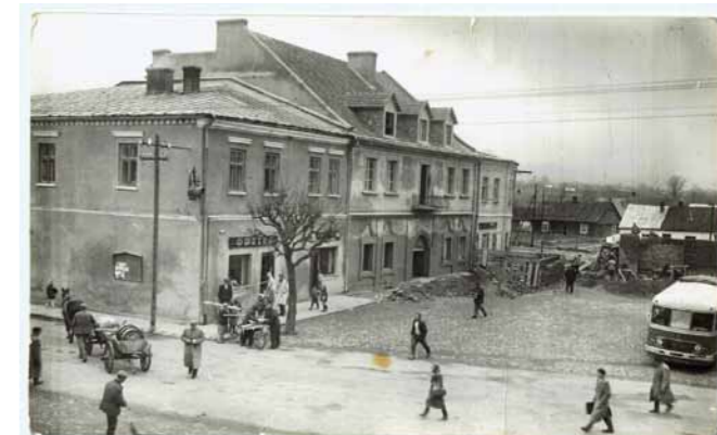
Budynek nr 25 na dukielskim Rynku po odbudowie wiosną 1961 roku
