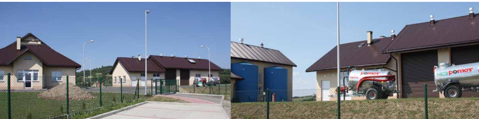
Oczyszczalnia ścieków w Sulistrowej, fot. kbr
