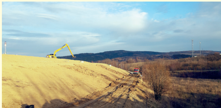
Prace na wysypisku podczas rekultywacji
