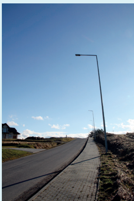
Oświetlenie uliczne przy drodze powiatowej w Głojscach
