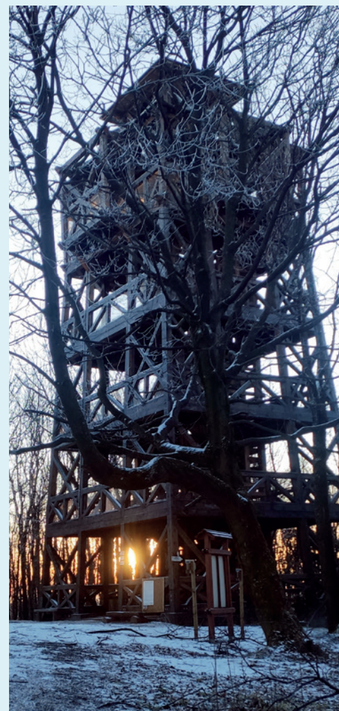
Wieża - stan aktualny
