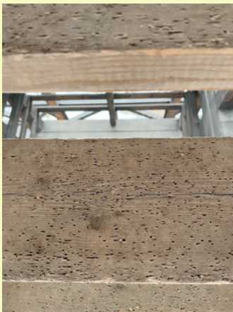
Poniszczone rakami schody na wieży widokowej na górze Cergowej
