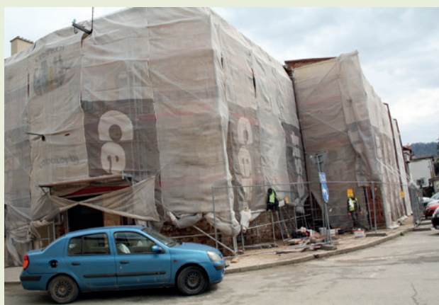
Początek prac remontowych
