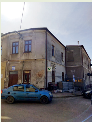
Kamienica przed remontem
