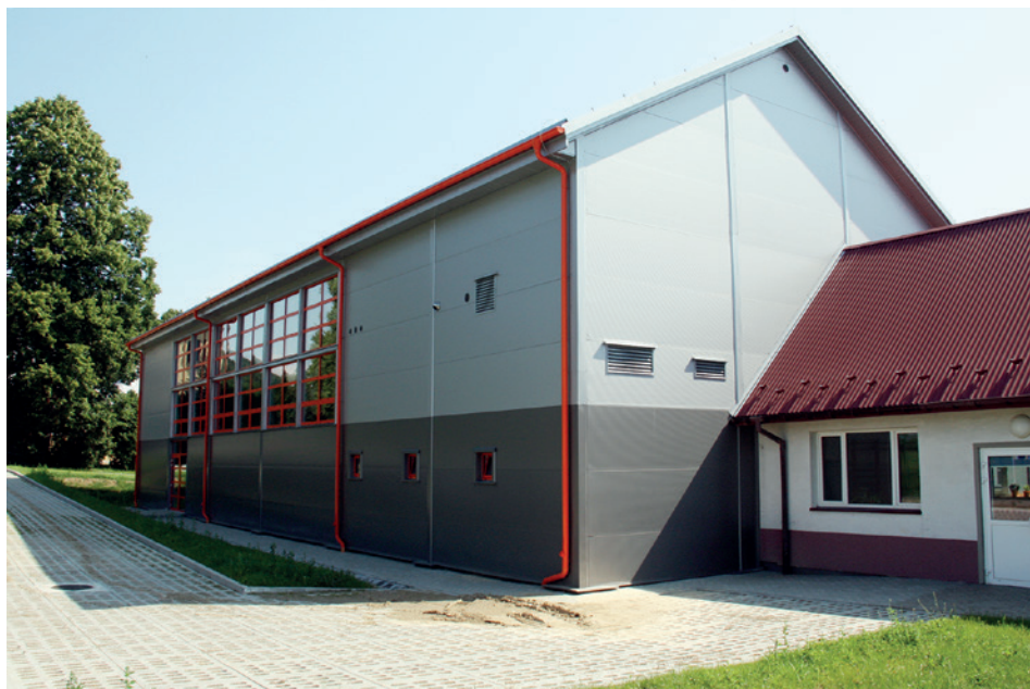
Widok na halę
