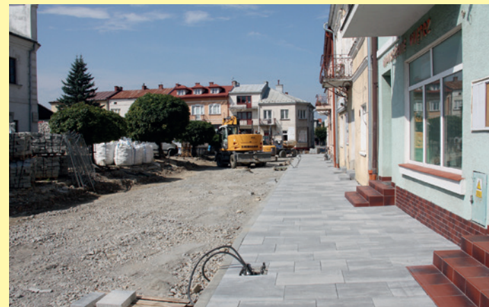
Fragment nowego chodnika przy pierzei północnej
