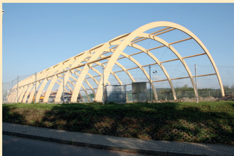
Konstrukcja drewniana hali
