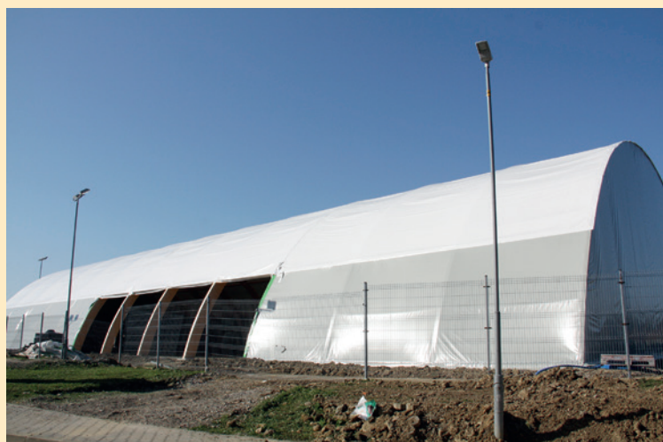
Pokryta konstrukcja hali
