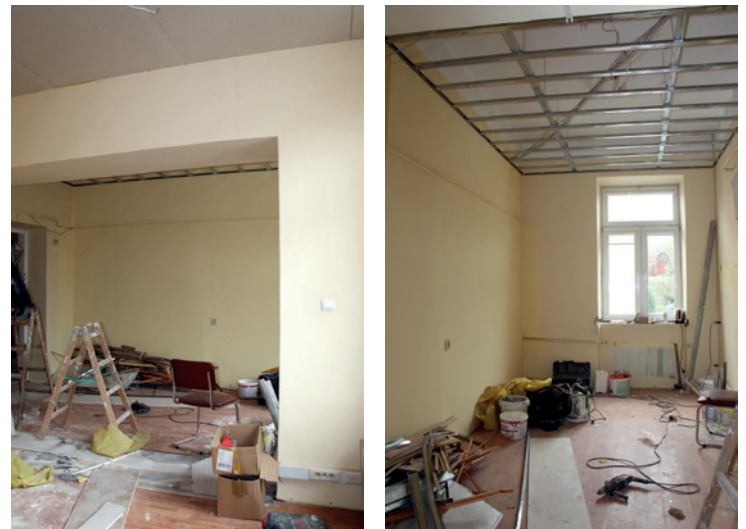
Prace budowlane w pomieszczeniach w kamienicy przy ul. Kościuszki 4
