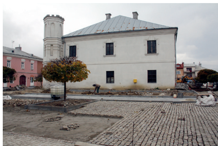
Układanie kostki na nawierzchni rynku
