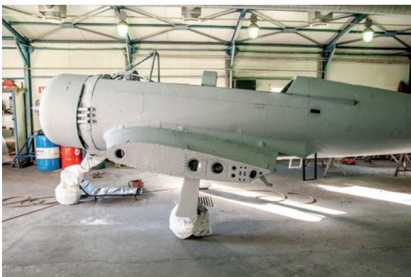
W trakcie prac remontowych
